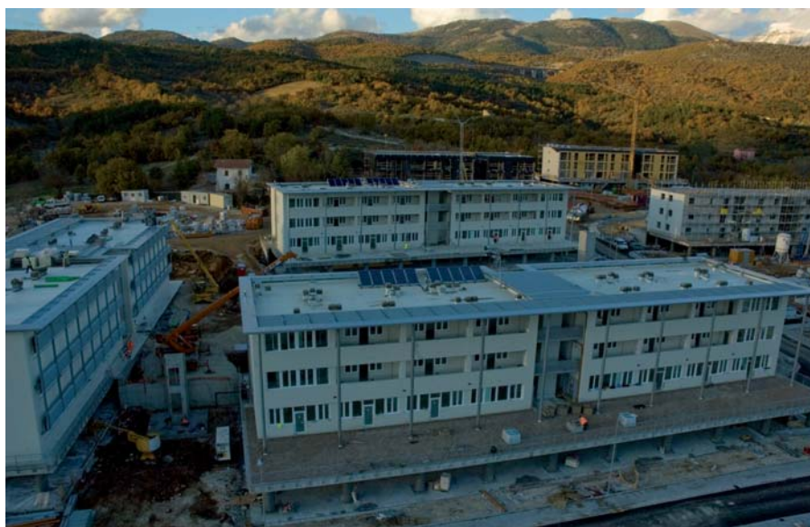
Vista esterna degli edifici completati External view of the completed work
