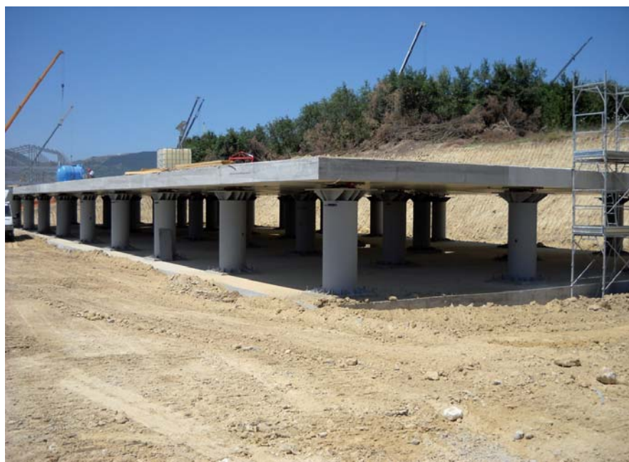
Piastra isolata sismicamente su cui è stato costruito ciascun edificio Seismic isolated plate on which each building was built
