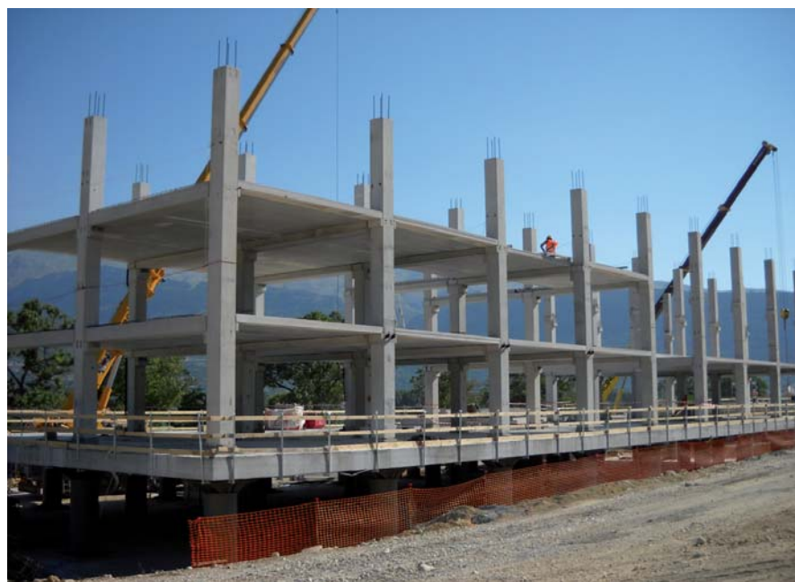
Seconda fase: costruzione dei solai Second phase: construction of the slabs
